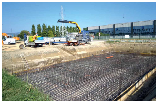
Il cantiere di Acque Veronesi già al lavoro a Belfiore
